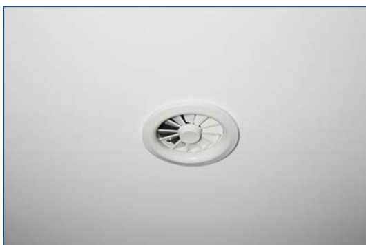
Montaż w suficie pełnym
