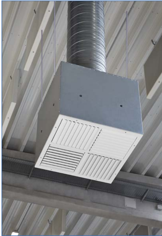
Montaż swobodnie podwieszony
