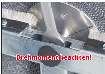
(10) Ist das Wärmerad in die entsprechende Neigung gebracht, wird durch ein Festziehen der Sechskantschraube die Position fixiert (Drehmoment entnehmen Sie Tab. 2)
