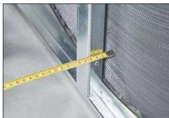
(11) Kontrollieren Sie die Zentrierung des Wärmerades in der vertikalen Gehäusemitte, Messpunkte siehe (9) auf beiden Seiten.
