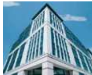
Business Center Glacis, Luksembourg Architekt: Jean Petit, Luksembourg – Atelier d'Art Urbain, Bruksela Konsultant: Masterplan Generalny wykonawca: A+P Kieffer Omnitec Sàrl
