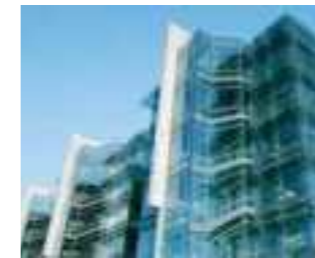
Chambre de Commerce, Luksemburg Architekt: Claude Vasconi & Partners, Paryż Konsultant: RMC Consulting Generalny wykonawca: ELCO S.A. – ABB Luksemburg – Climalux S.A.
