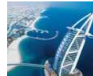
Burj al Arab, Dubai Architekt: Tom Wright, Atkins Middle East – W.S. Atkins & Partners, Epsom, UK Konsultant: W.S. Atkins & Partners Generalny wykonawca: B.K. Gulf
