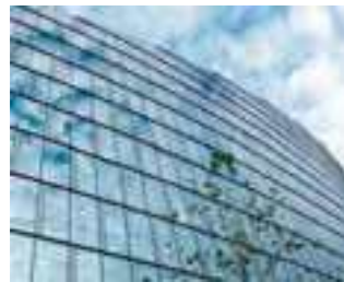
Main-Triangel, Frankfurt nad Menem Architekt: Architect Group N+M GmbH, Offenbach Konsultant: Pettersson + Ahrens Generalny wykonawca: Kretz + Wahl Gebäudetechnik GmbH & Co. KG
