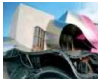
Marqués de Riscal, Rioja Architekt: Frank O. Gehry, Gehry Partners, LLP, Los Angeles Konsultant: IDOM (Ingeniería, Arquitectura y Consultoría) Generalny wykonawca: AXIMA, Sistemas e Instalaciones, S.A.
