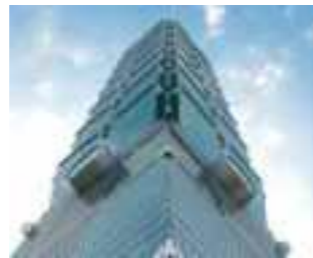
Tai Pai Financial Centre, Taipeh Architekt: Chang Yong Lee & Partners, Taipeh (Tajwan) Konsultant: Continental Consulting Generalny wykonawca: Shynrio
