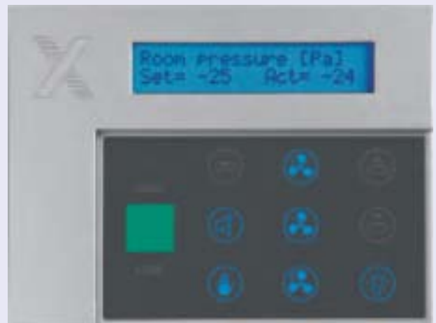
Ekran panelu obsługowego z wartością nastawy i wartością aktualną w układzie regulacji różnicy ciśnienia
